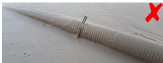
Betonnagels i.p.v. pluggen:
